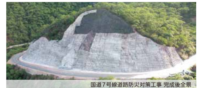
国道7号線道路防災対策工事 完成後全景
