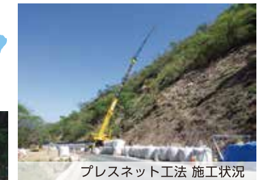
プレスネット工法 施工状況
