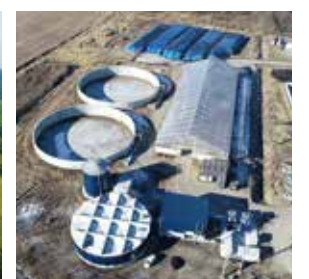
北海道 豊富町「バイオガスプラント」
