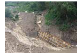
◀ 降雨時の法面状況
