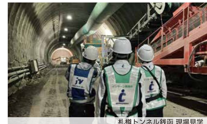
札幌トンネル銭函 現場見学
