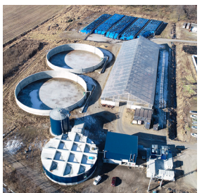
北海道 豊富町「バイオガスプラント」
